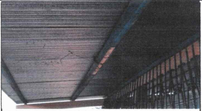
Foto 2: se observa estructura del lado interno.
