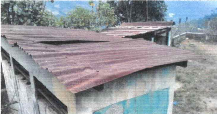
Foto 5: vista de techo de baños.
